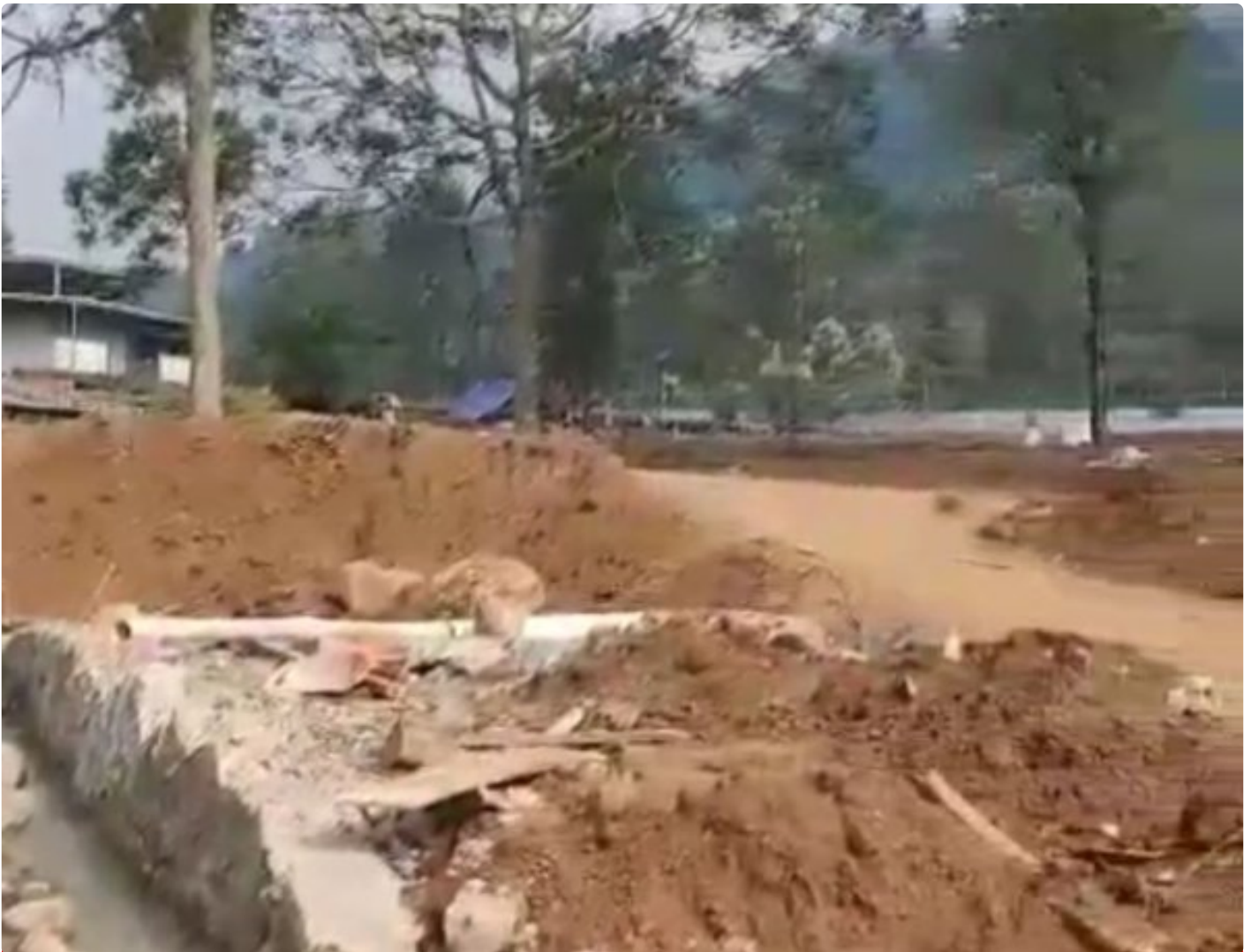
Photo: Kondisi Kebun tea yang sedang di bangun pariwisata
